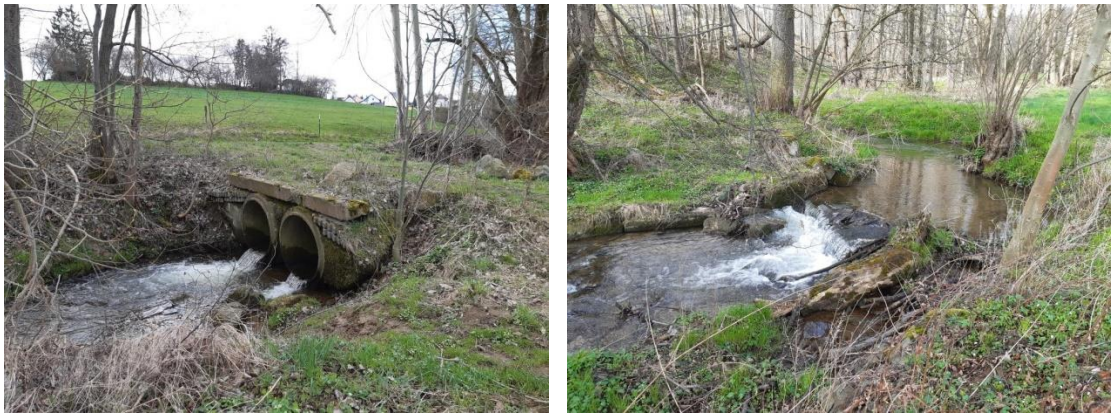
Abbildung 8: Kompensationsmaßnahmen E1 Und E2 am Plotzbach (Foto SCZ vom 03.04.2023)
